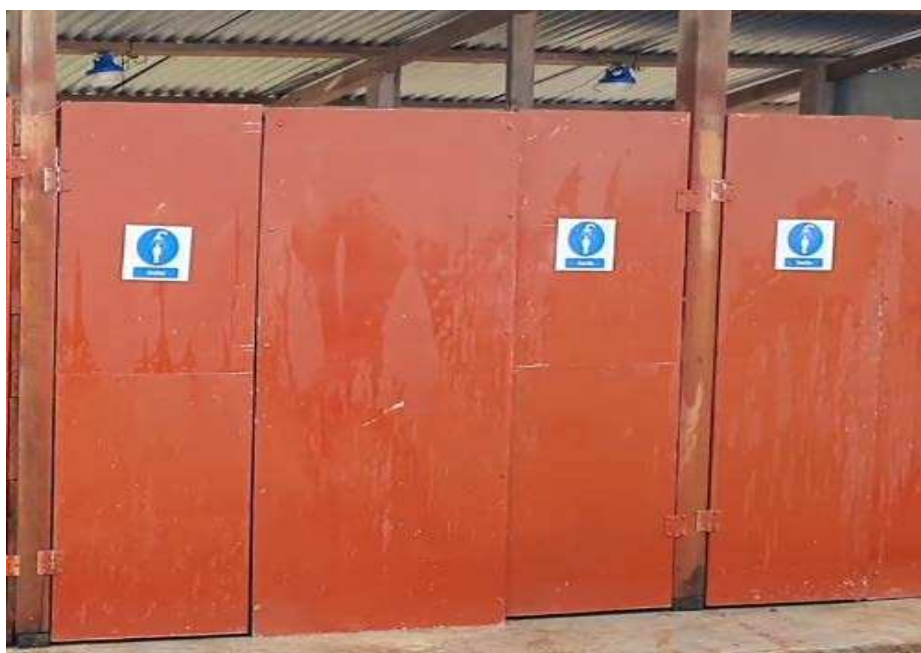
Área de duchas y servicios sanitarios en la ERM de San Vicente. Presencia de señalizaciones.
