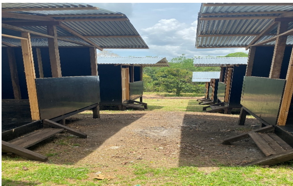
Unidades habitacionales donadas por la OIM ubicadas en la ERM de Lajas Blancas.
