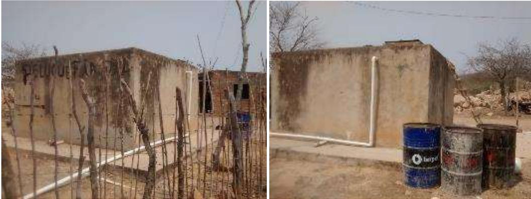
Se encuentra actualmente en mantenimiento, cuenta conexión con la línea de conducción, según el personal encargado de las adecuaciones se va a encharpar internamente y a recubrir nuevamente en la parte exterior.
