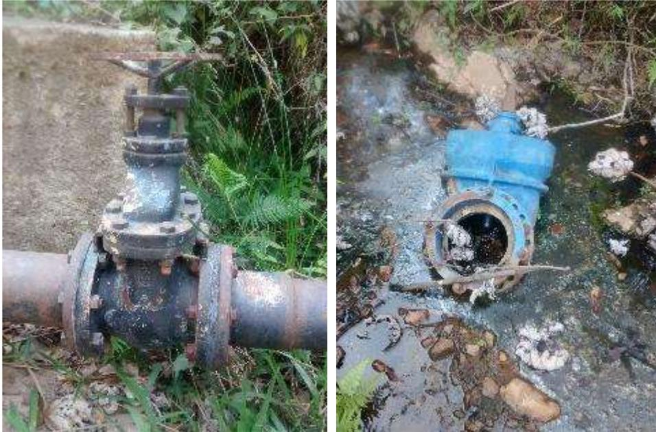
Las válvulas que permiten controlar el paso del agua hacia las albercas ubicadas en diferentes puntos de la comunidad se encuentran deterioradas y rotas lo que imposibilita tener un control del flujo de agua enviado hacia las comunidades cuando se cuenta con el líquido.
