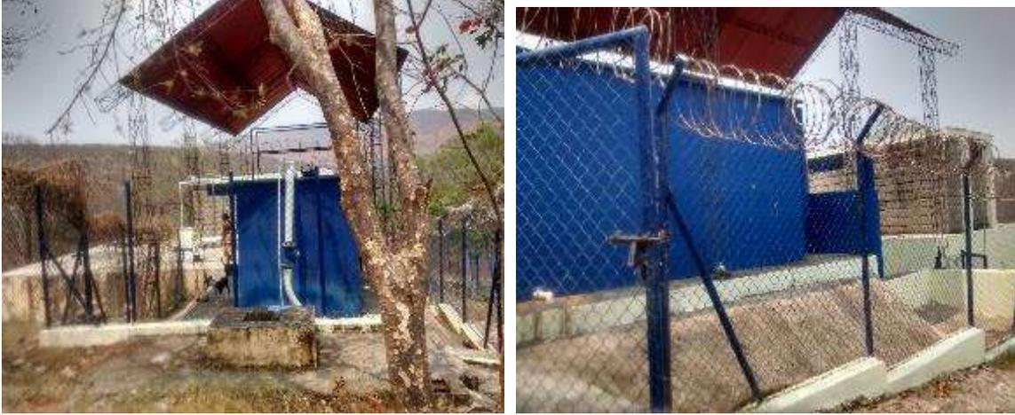
El agua captada es conducida hasta este compartimento cuyas medidas son de 4,00 por 2,00 mtr con 2,20 mtrs de altura; en este comparimento debia funcionar anteriormente los proceso de cuagulación-floculación y filtración, pero debido al abandono y a la perdida de los equipos es utilizado actualmente para que decante todo el material que pueda haber arrastrado el agua.
