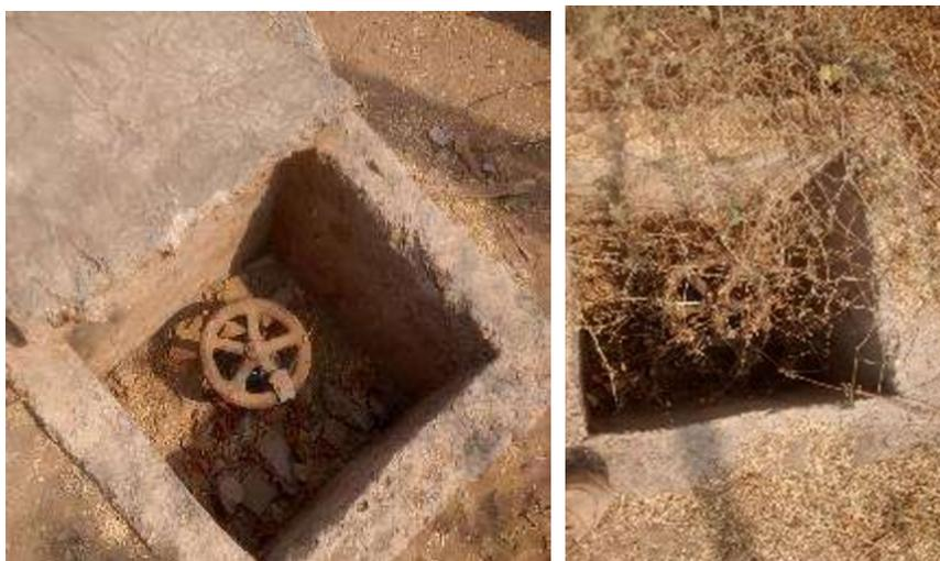
Los pozos inician con tuberías independientes ya que se encuentran ubicados en lugares diferentes, pero en un punto se interceptan y continúa solo una línea de conducción hacia las albercas; las válvulas que se observan en la ilustración 21 controlan el paso del agua de cada uno de los pozos.
