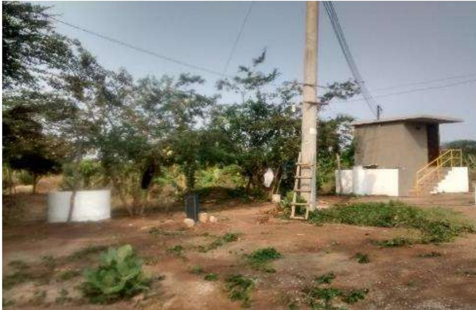
Como se observa en la ilustración 28 los pozos se encuentran ubicados en un lugar abierto, no tiene ningun tipo de cercamiento o señalización, en el area se encuentra ubicado el cuarto de control desde donde se realiza la manipulación de las bombas para el llenado de las albercas.
