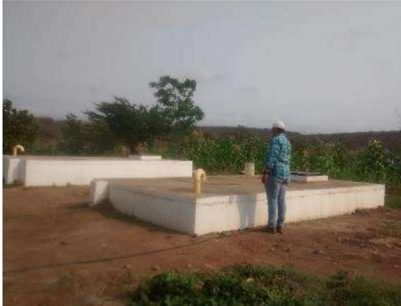
Los tanques están en buenas condiciones, no se filtran, las tapas tienen seguridad, hay un personal encargado de su limpieza y mantenimiento.
