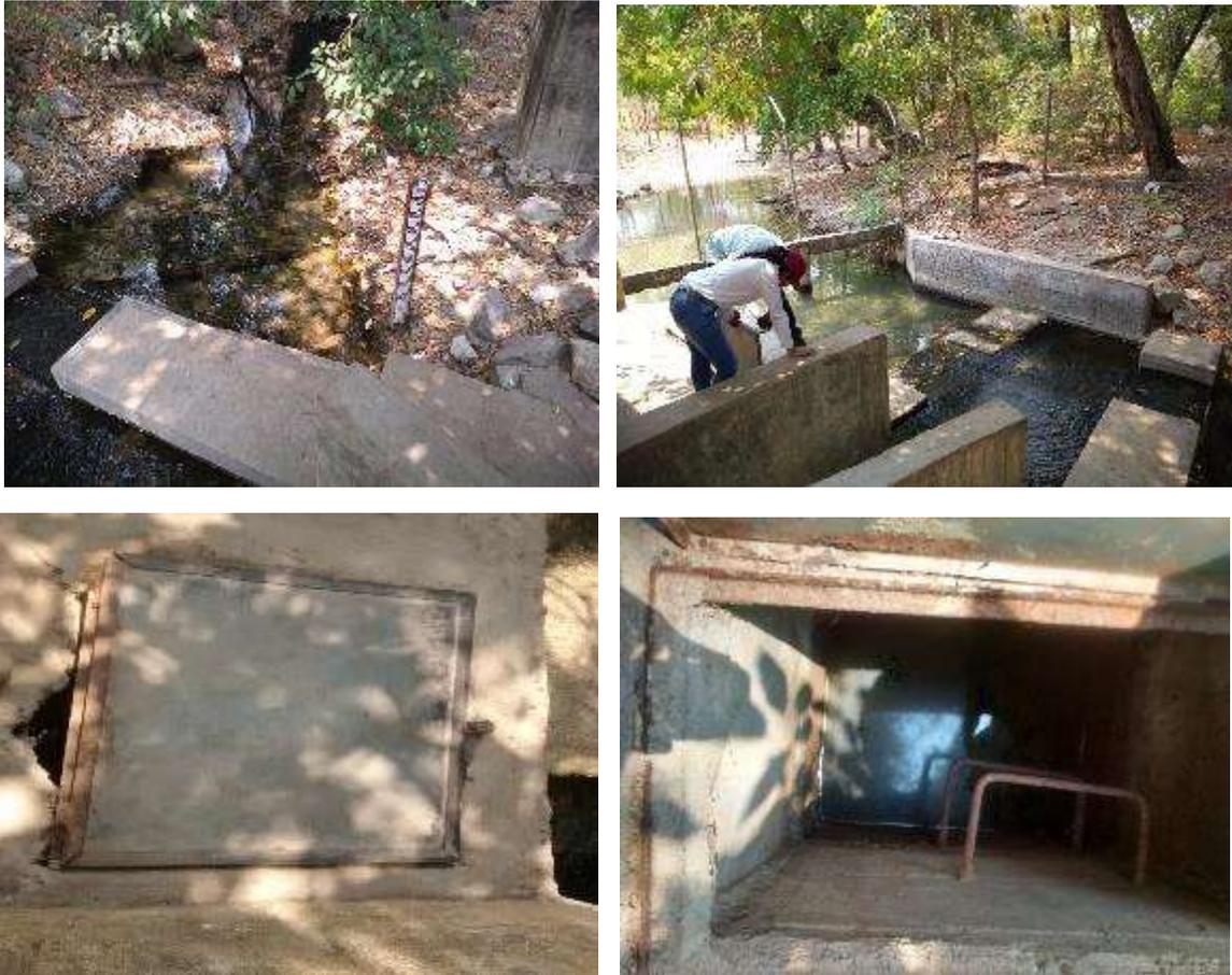
El sistema de captación de la comunidad del rodeo es un pequeño manantial o nacimiento de agua, donde parte del agua generada o producida por este es conducida a través de un sistema desarenador, para retirar la mayor cantidad posible de sólidos sedimentables y posteriormente el líquido es llevado a la alberca semienterrada ubicada en el cuarto de control.
