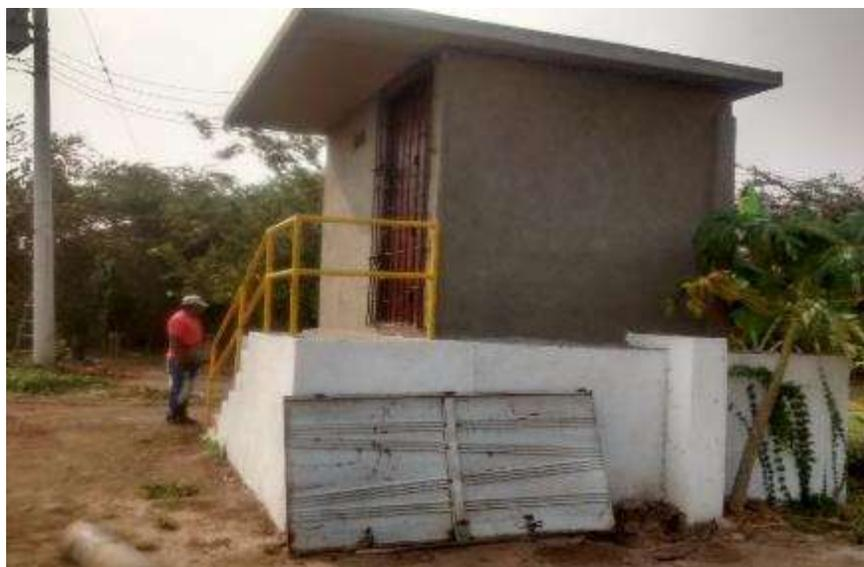
En el cuarto de control están ubicados los diferentes tableros eléctricos que permiten la manipulación de las bombas sumergibles que se encuentran en cada pozo, así como las bombas ubicadas en los tanques semienterrados para la impulsión del agua hacia los tanques ubicados en cada Resguardo.
