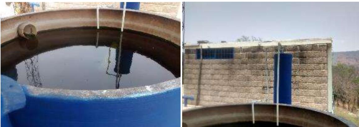
El agua es conducida desde el tanque cilindrico hacia el tanque de almacenamiento o alberca, para posteriormente ser enviado a los diferentes sectores de la comunidad.
