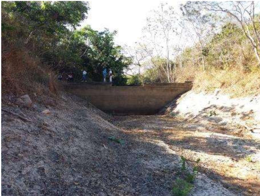
La comunidad del Cerro se abastece de una represa ubicada en la parte alta del Resguardo, la estructura se encuentra en buenas condiciones, presenta pequeñas infiltraciones en los laterales debido a la falta de mantenimiento y de una buena operación de esta.
