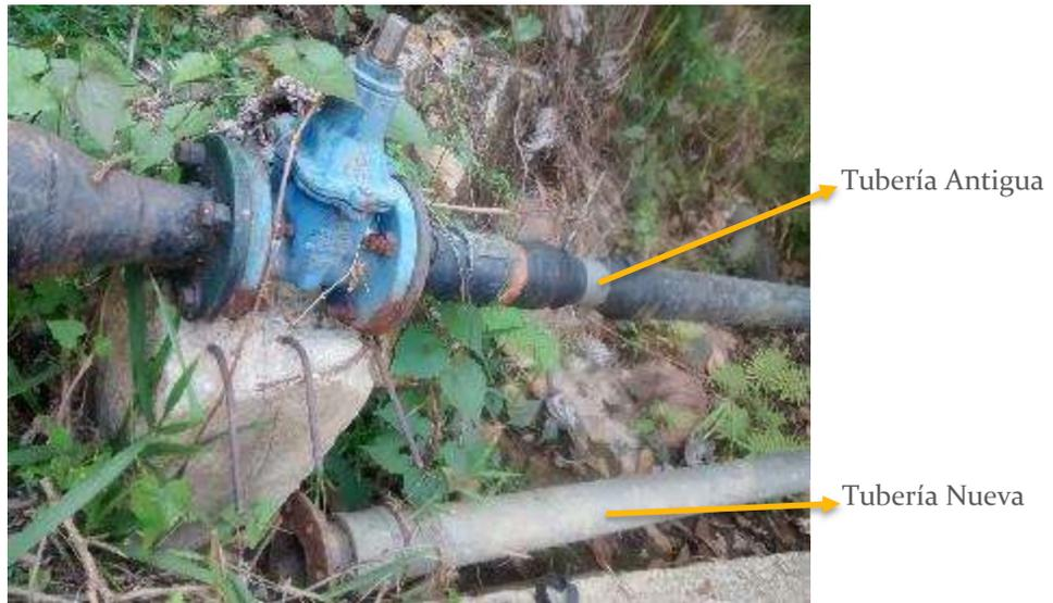
Durante el recorrido de la tubería nueva de conducción se encontraron reducciones de diámetro de 8" 6" y 3" y no se encontró ningún tipo de válvulas o ventosas.
