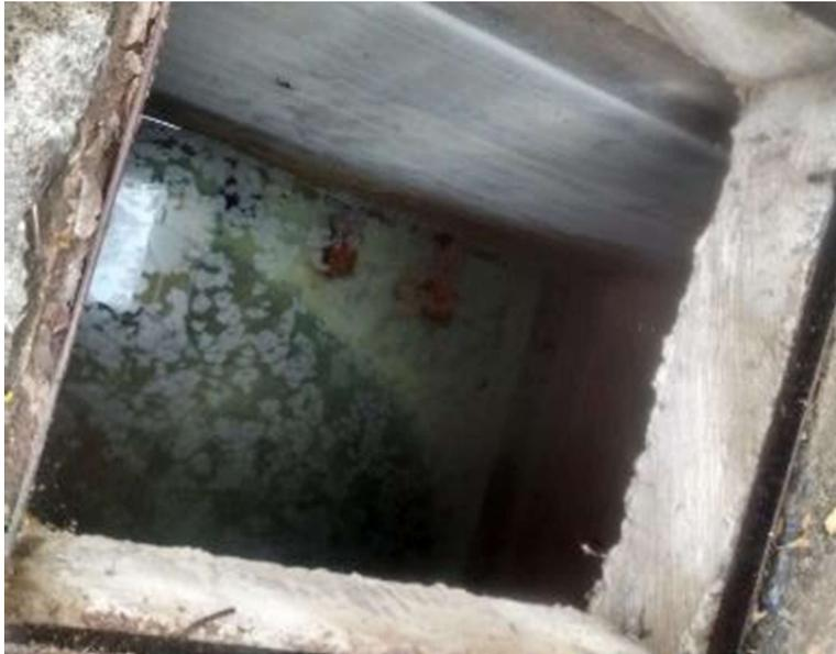
El tanque de almacenamiento tiene 8,40 mtr por 13,50 mtr y 2,30 mtr aproximadamente de profundidad, dicho tanque no cuenta las condiciones de salubridad necesarias para el almacenamiento del agua, se evidencia poca higiene y sedimentos de arena en el fondo; las tapas no tienen ningún tipo de seguridad, las instalaciones de la planta se encuentran totalmente abandonadas.
