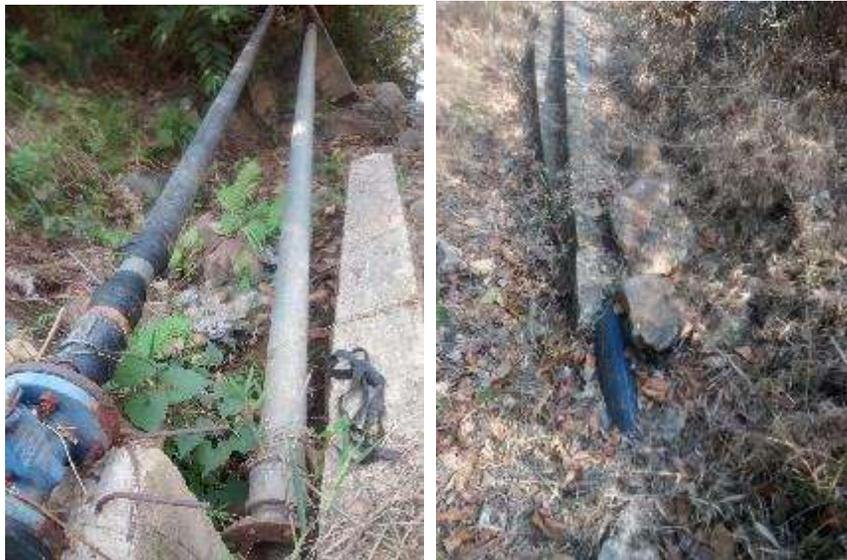
Como se puede observar parte de la tubería se encuentra parcialmente cubierta por concreto, habiendo sectores en los que está totalmente descubierta o incluso alzada por troncos, el recorrido inicia desde la represa y va al costado del camino vehicular hasta llegar a la comunidad que se encuentra metros abajo.
