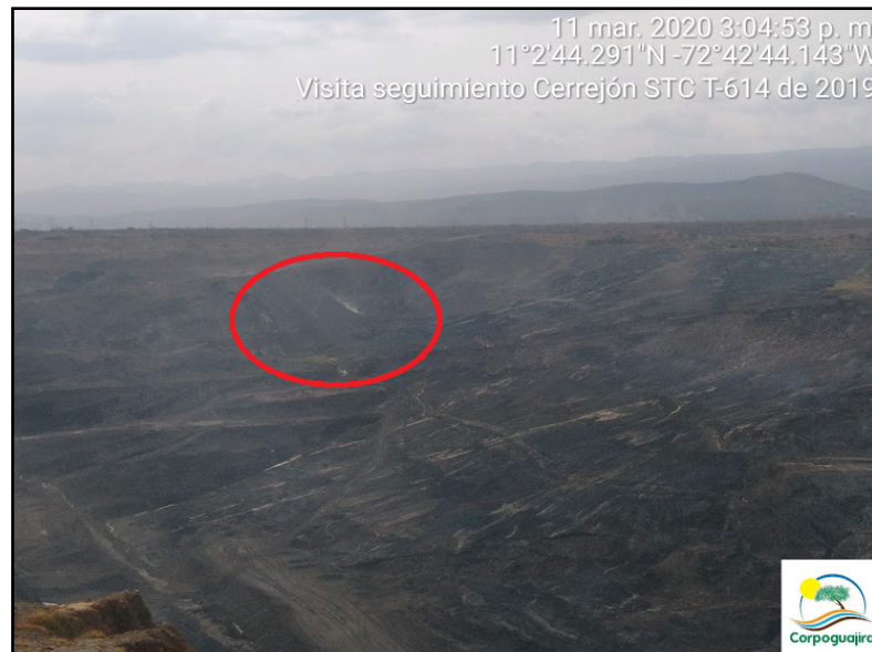
Figura 9. Incendio de manto de carbón en el Endwall del Tajo Patilla. Fuente: CORPOGUAJIRA. Radicado 2020051592-1-000 del 2 de abril de 2020
