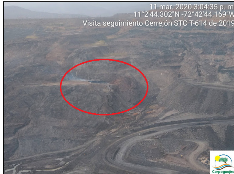
Figura 8. Incendio de manto de carbón en el Tajo Patilla.
