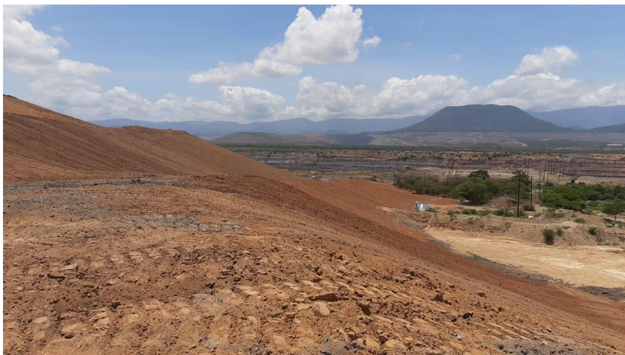
Fotografía No 2. Enriquecimiento del área con suelo orgánico
