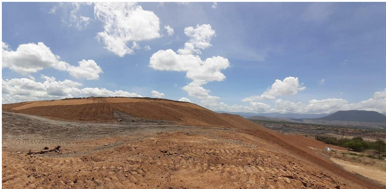
Fotografía No 1. Enriquecimiento del área con suelo orgánico
