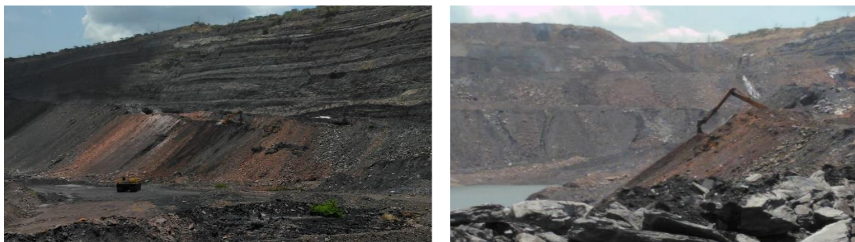
Fotografías No 8 y 9. Retroexcavadora brazo largo trabajando en la pared alta
