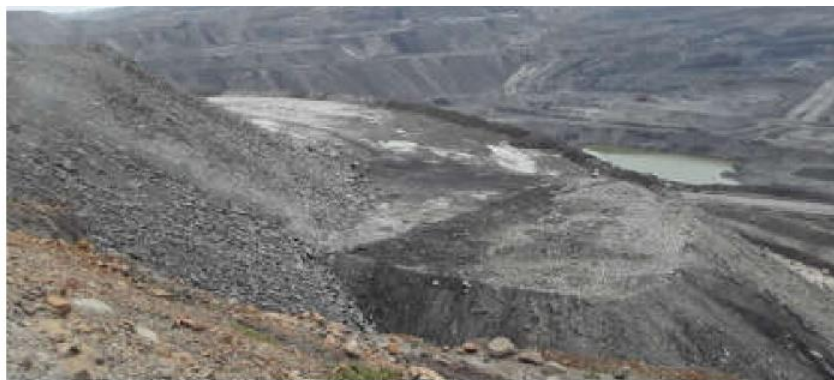
Fotografía 10. Avance proceso de relleno área para control de autocombustión en el rango de 5 Km
