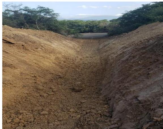
**Fotografías 15 y 16. Canales adicionales construidos**
