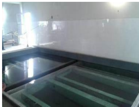
Substituição do leito filtrante dos filtros "Russos" na ETA II de Colatina
