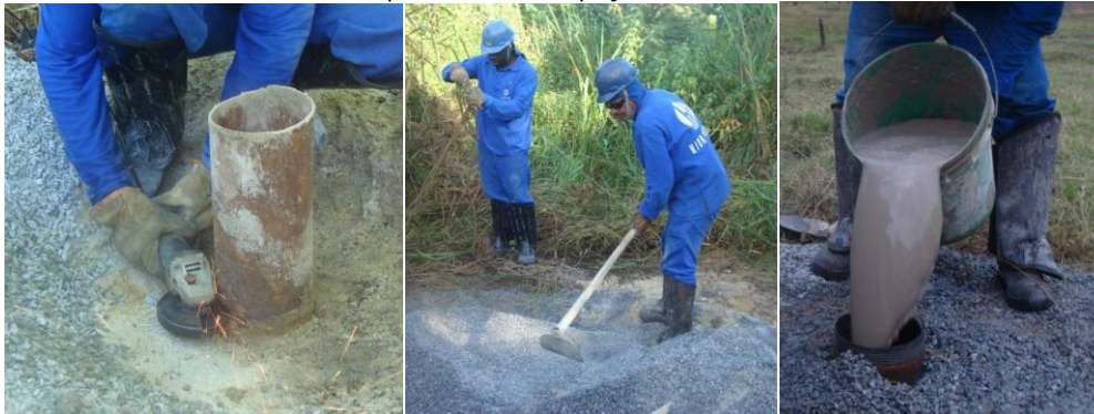
Tamponamento dos poços em Itueta.
