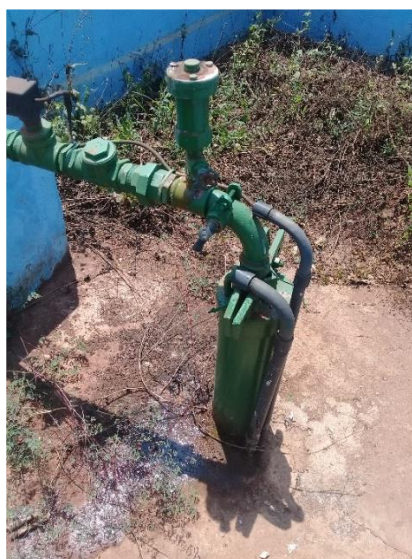
Reservatório antigo, com capacidade de 15 m 3 , em Gesteira
