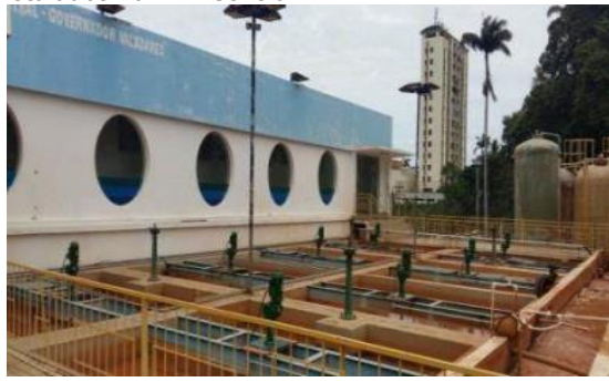
Imagens dos agitadores instalados na ETA Central.
