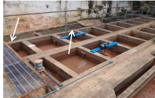
Implantação de acesso seguro às áreas dos floculadores e decantadores, evidenciado.
