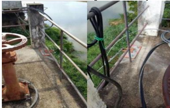
Novo sistema de ancoragem e alimentação elétrica da Balsa de captação da ETA II
