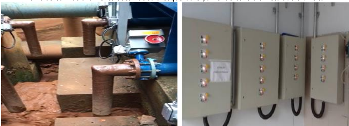
Válvulas com acionamento automático à esquerda e painel de controle instalado à direita.
