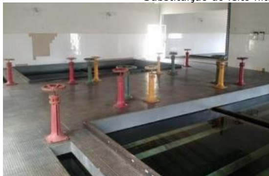
Substituição do leito filtrante dos filtros "Rápidos"
