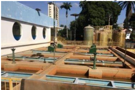
Imagens dos agitadores instalados na ETA Central.
